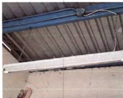
Foto 4: Reparación de todo el cableado eléctrico, lámparas LED, Plafoneras, Sustitución de inerruptores y tomacorrientes dobles
