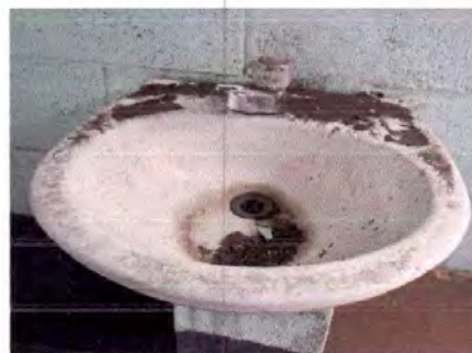
Foto 6: Sustitución de 4 lavamanos
