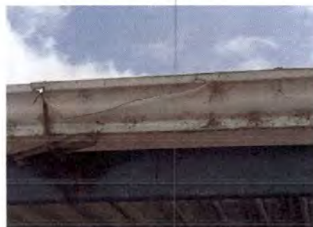
Foto 4: Sustitución de 27 ml. de canal, 4 tubos de caída de agua
