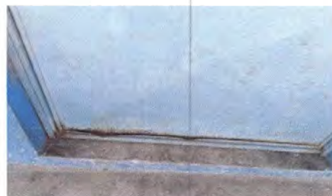
Foto 6: Mantenimiento de 3 puertas de metal
