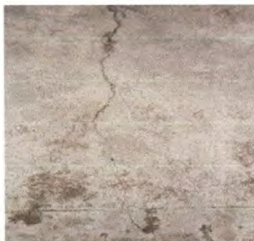
Foto 3: Sustitución de 20 m2 de tota de cemento
