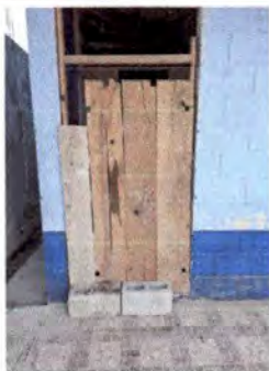
Foto1: Sustitución de una puerta de mandera por una de metal y una de metal
