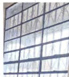
Foto 2: mantenimiento de 30 Mts.2 de ventanales
