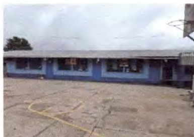
Foto1: Mantenimiento de 6 puertas de metal
