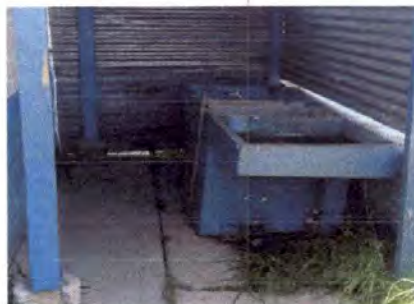
Foto 2: reparación de 17 m2 de piso de concreto
